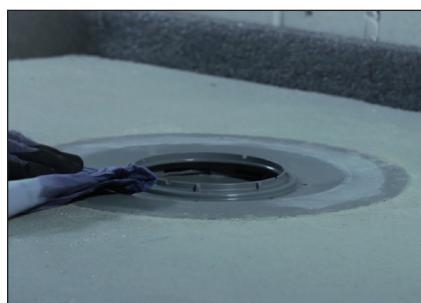
DE: Dichtflansch leicht-feucht reinigen.
