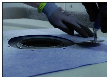
DE: Dichtmanschette passgenau positionieren. Innenrand des Dichtflansches mit Spachtel nachfahren um Kleberaupe gleichmäßig zu verstreichen.
