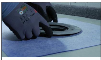
DE: Gegenflansch passend auflegen, mit beiliegenden Schrauben handfest befestigen. Beim Anziehen darauf achten, dass immer zwei diagonal gegenüberliegende Muttern nacheinander angezogen werden
