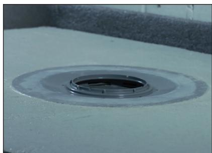
DE: Bodenablauf bereits gemäß Einbauanleitung (016-833 / 016-830) im Estrich eingebracht.
